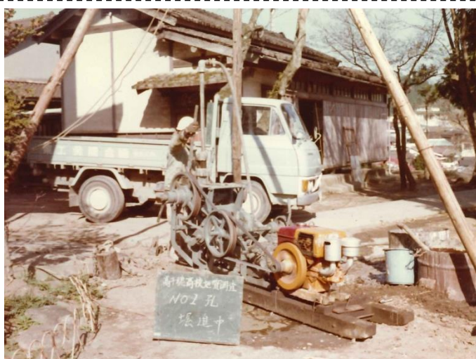
【写真左:ハンドフィード式による建築基礎調査(昭和 47(1972)年)】
