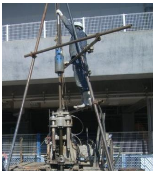
【写真右:“自動落下法”による標準貫入試験(JIS 改正後)】
